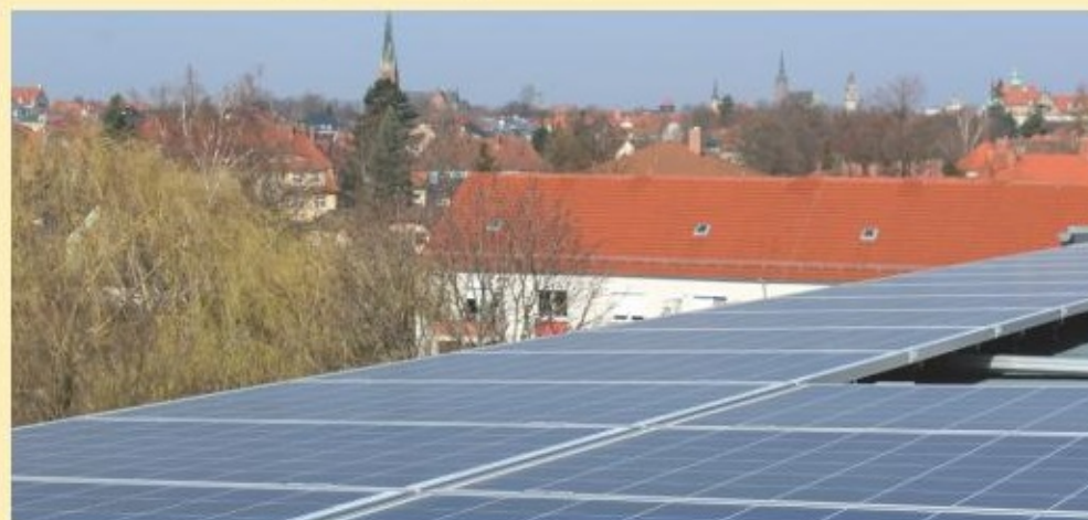
Über eine Solaranlage auf dem Dach des Fünfgeschossers beziehen die Bewohner einen Großteil ihres Stromes.
